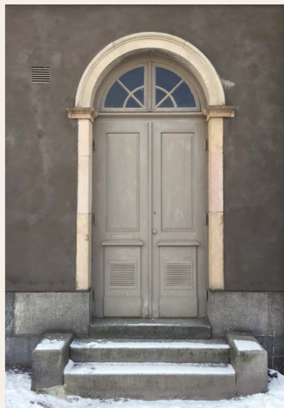
Port i kasernbyggnaden, 2018.
